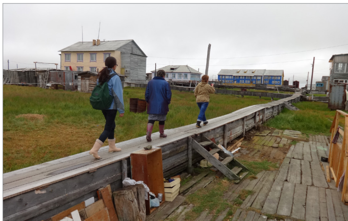
Рис. 1.15. Дорога к школе (с. Русское Устье Аллаиховского района)
