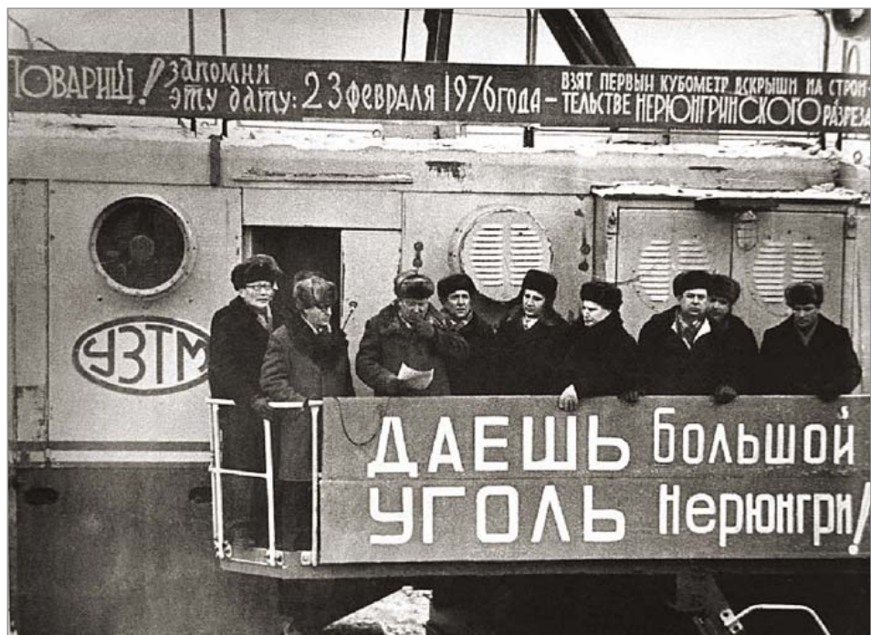
Разрез «Нерюнгринский». Митинг по случаю начала вскрышных работ на «Большом разрезе». 23 февраля 1976 г.
