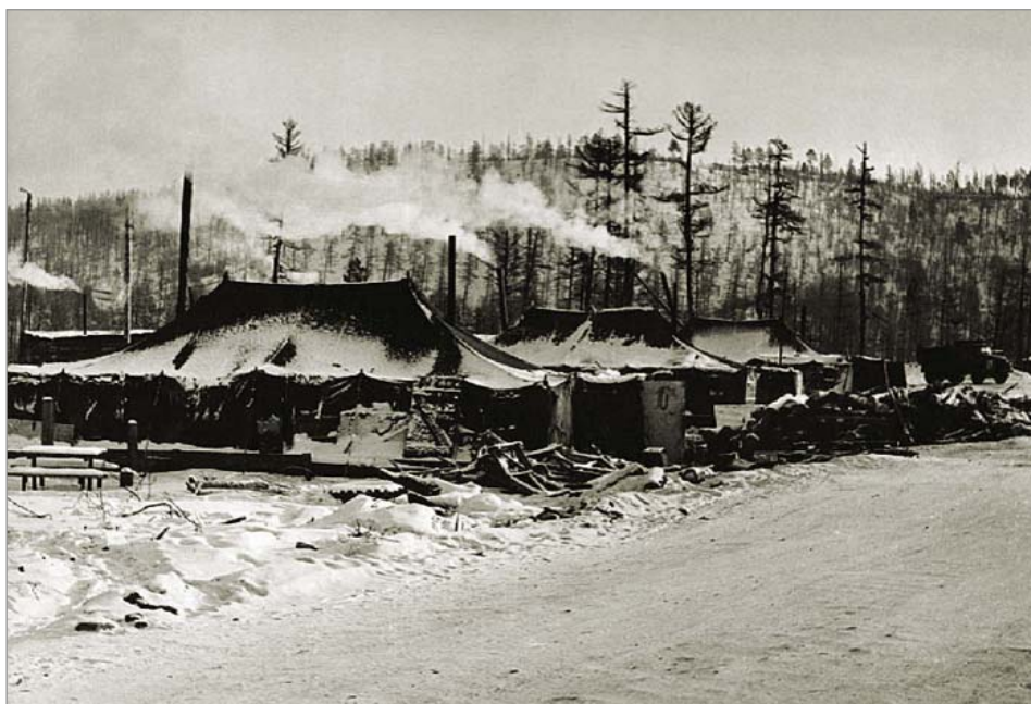
Палаточный городок первостроителей г. Нерюнгри. 1975 г.
