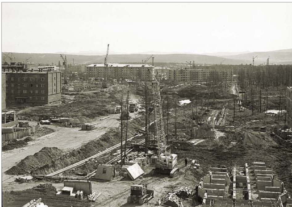
Строительство квартала «В» г. Нерюнгри. Июнь, 1982 г.
