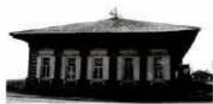
Дом Киренских на перекрестке пр. Ленина и ул. Строда
