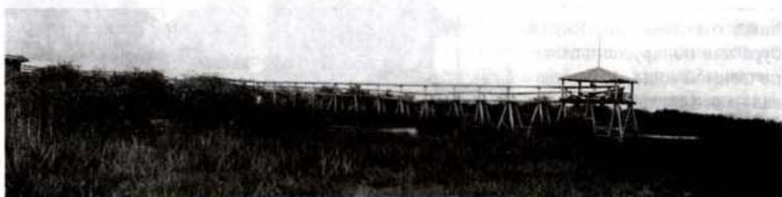
Водозабор и очистительное сооружение
