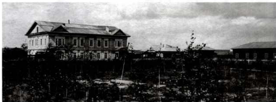
Канцелярия Областного управления. Вид из сада И. И. Крафта
