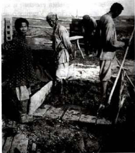
Кустарное производство кирпича. Замешивание глины
