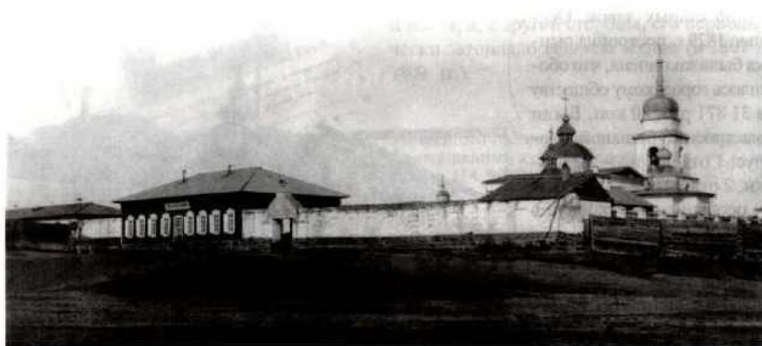
Здание Якутской духовной консистории и Спасская церковь монастыря
