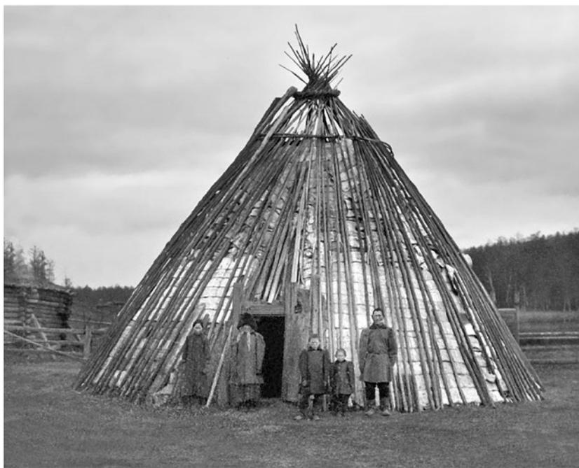
Рис. IV.25. Якуты. Стационарное коническое жилище, покрытое берестяными полотнами (*могол ураса*). Из фотоматериалов ОАиЭ ИГиИПМНС СО РАН.
