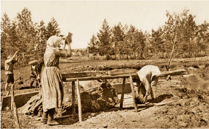
Выделка кирпича кустарным способом в пригороде Якутска. Начало XX в.
