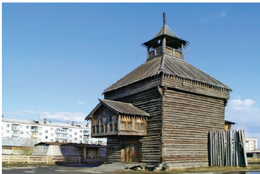
Башня Якутского острога.
