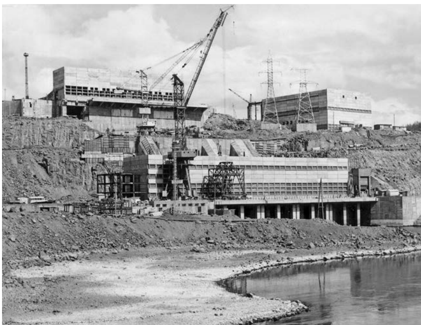
Строительство Вилуйской ГЭС. 1975 г. Фотофонд НА РС (Я), б/н.
