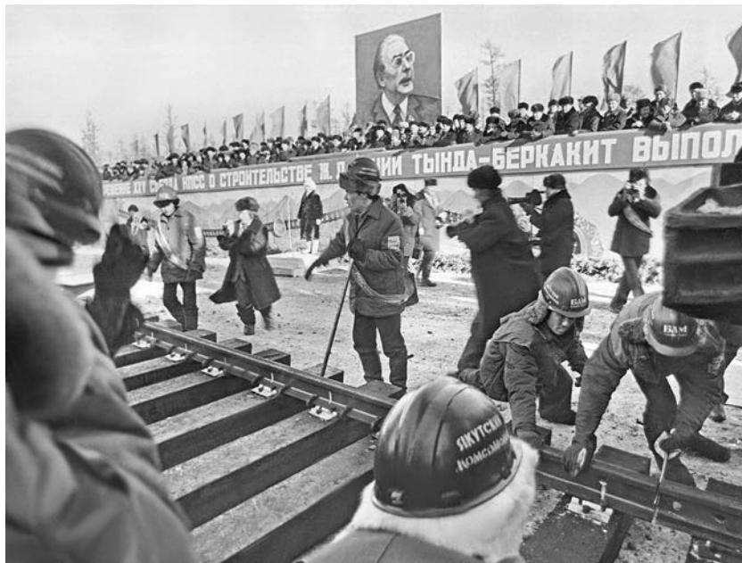
Отряд «Якутский комсомолец» на укладке последнего звена рельсов на станции Беркакит. 29 октября 1977 г. Фотофонд НА РС (Я), б/н.
