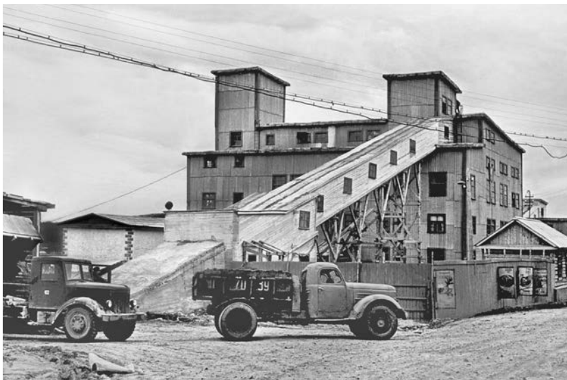
Общий вид алмазной обогатительной фабрики № 2 в г. Мирном. 1960-е годы. РГАКФД, б/н.
