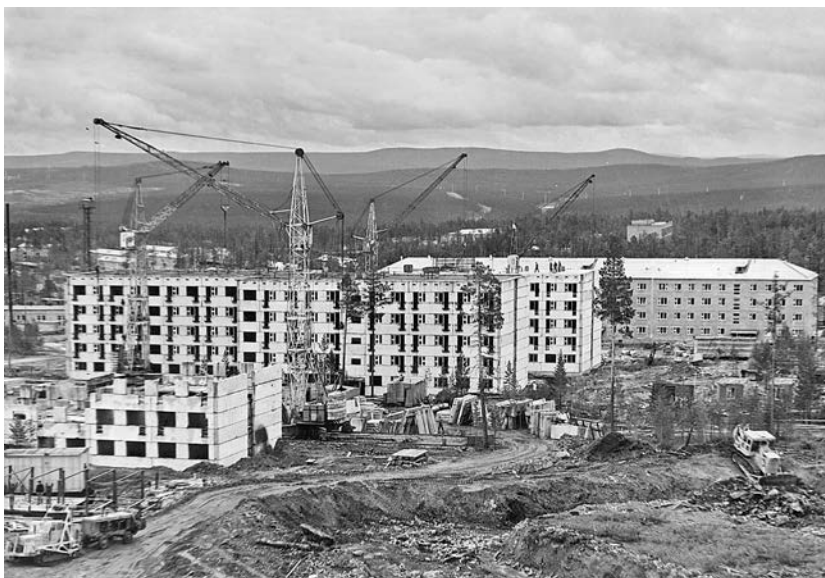
Строительство г. Нерюнгри. 1982 г. Фотофонд НА РС (Я), б/н.
