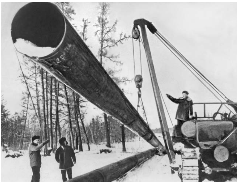
Газопровод Таас-Тумус — Якутск. 1967 г. ЯГОМИКНС, КПФ-21760.
