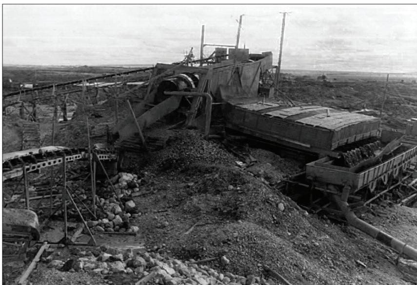
Рисунок 2. Промывочный прибор. ГОК «Куларзолото». 1979 г. Фотофонд НА РС(Я). Д. 4687.
